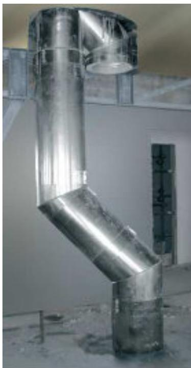
**Descrizione** Condotta circolare lineare tipo CRS con stacco a BRAGA con sezione non inferiore a  $0,10 \text{ mm}^2$  per la ventilazione verticale di locali adibiti a magazzino, autorimesse, ecc. costituito da elementi lineari ed elementi con stacco laterale a braga tipo SHUNT. Tali manufatti dovranno essere costituiti da una miscela a basedi silicato di calcio, perlite, vermiculite, ossidi e leganti idraulici rivestiti internamente ed esternamente da lamiera in acciaio zincato.
